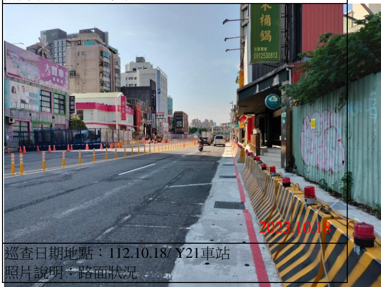
巡查日期地點：112.10.18/ Y21車站 照片說明：路面狀況
