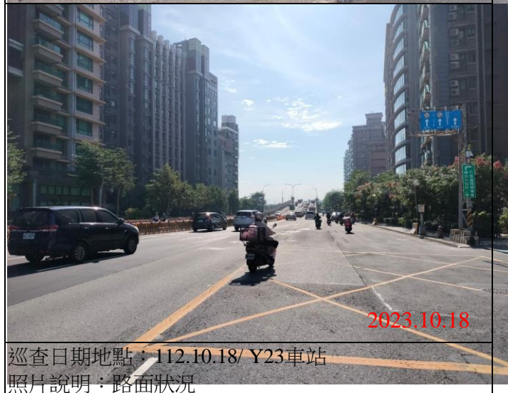
巡查日期地點：112.10.18/ Y23車站 照片說明：路面狀況
