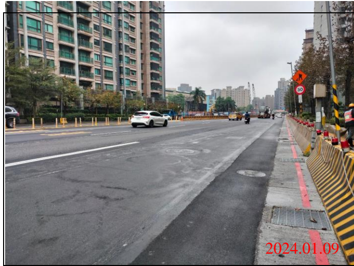
巡查日期地點：113.01.09/ Y23車站 照片說明：路面狀況
