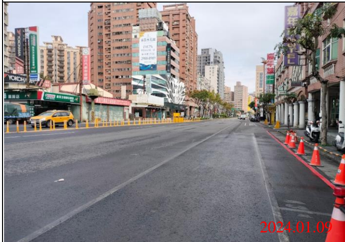
巡查日期地點：113.01.09/ Y21車站 照片說明：路面狀況
