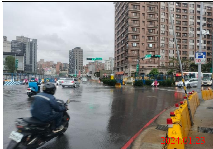
巡查日期地點：113.01.23/ Y22車站 照片說明：路面狀況
