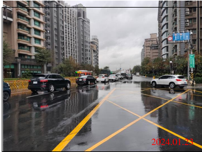
巡查日期地點：113.01.23/ Y23車站 照片說明：路面狀況
