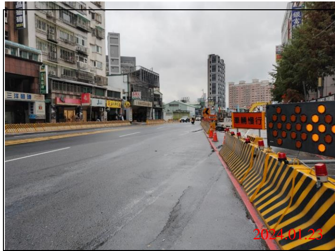
巡查日期地點：113.01.23/ Y22車站 照片說明：路面狀況
