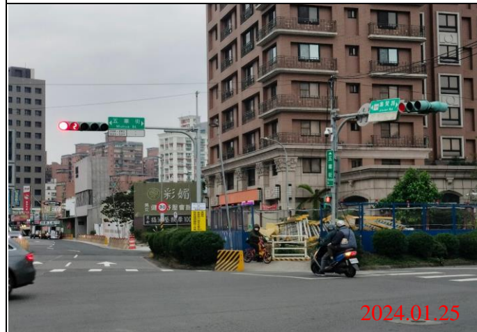
巡查日期地點：113.01.25/ Y22車站 照片說明：牌面設置狀況
