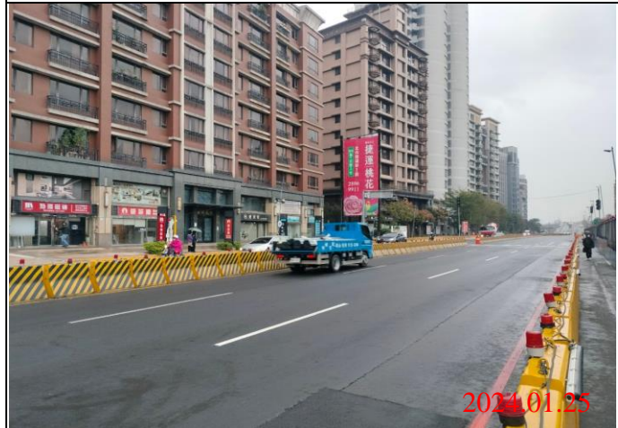
巡查日期地點：113.01.25/ Y23車站 照片說明：路面狀況
