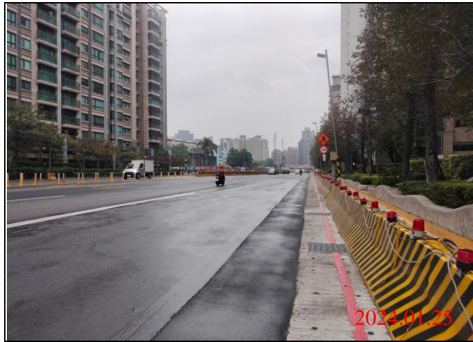
巡查日期地點：113.01.25/ Y23車站 照片說明：路面狀況
