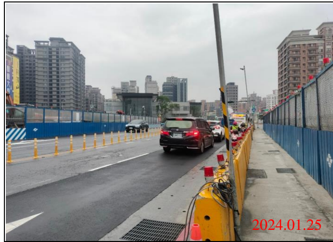
巡查日期地點：113.01.25/ Y22車站 照片說明：路面狀況
